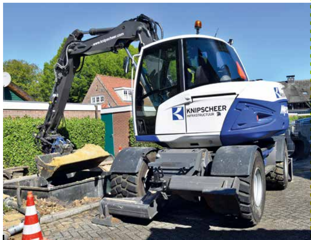
Middels een bekisting wordt het gat voor de afvalcontainer gegraven. De prachtig in bedrijfskleuren gespoten machine is voor Knipscheer alweer de derde Mecalac.
