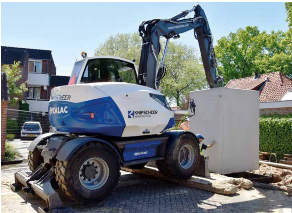
Het hijsen van een 6,5 ton zware put is voor de 15MWR geen probleem. Dankzij de camera aan de binnenkant van de giek kan de machinist goed in de put kijken en deze nauwkeurig plaatsen.
